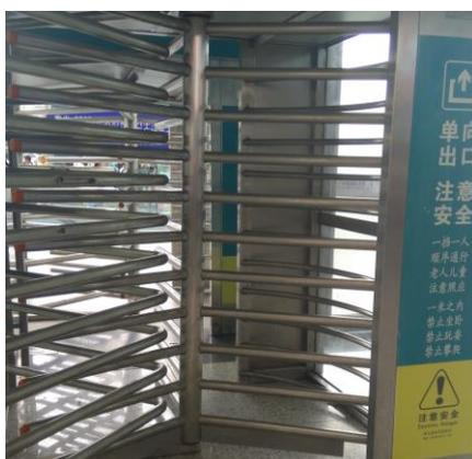
图 7.深圳北高铁站单向出口的梳型门页
